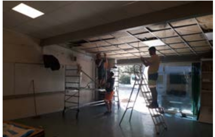
Changement des plafonds et du système d'éclairage LED pour certaines salles de l'école élémentaire.
