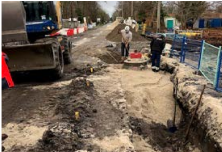
Avenue du lac : remplacement des canalisations eau potable et assainissement en cours de réalisation. Une grosse partie des travaux s'achèvera fin mai pour laisser place à l'installation des canalisations gaz et ce jusqu'à début juillet. La circulation sera alternée durant la prestation gaz.
