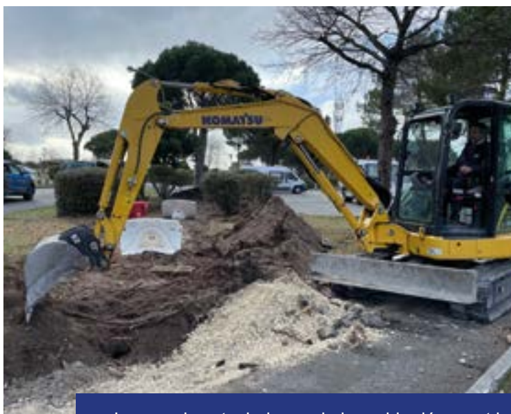
Les services techniques de la mairie décapent les enrobés déformés par les racines des pins parasols à HOURTIN Port. Une purge de l'assise est effectuée afin d'éliminer les racines. Ensuite une nouvelle couche d'enrobé viendra prochainement refermer la chaussée.
