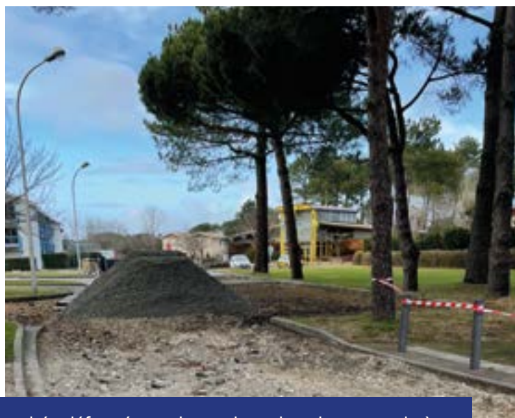
Les services techniques de la mairie décapent les enrobés déformés par les racines des pins parasols à HOURTIN Port. Une purge de l'assise est effectuée afin d'éliminer les racines. Ensuite une nouvelle couche d'enrobé viendra prochainement refermer la chaussée.
