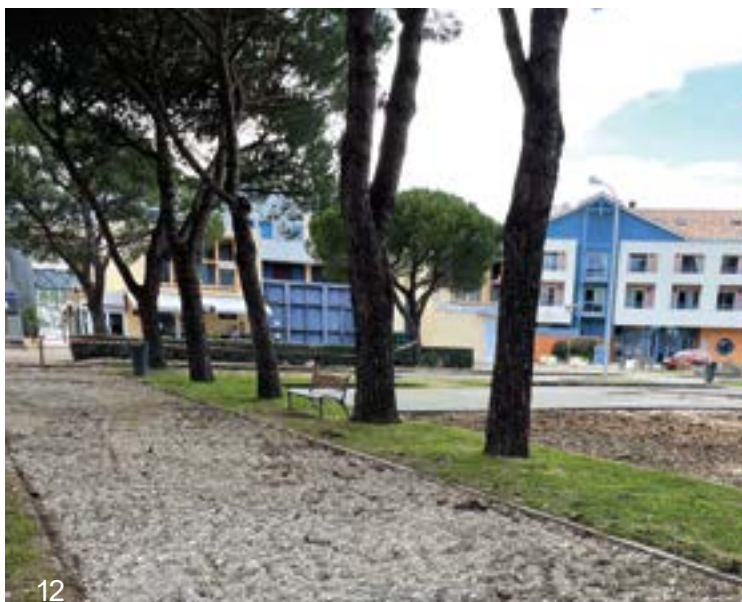
Les services techniques de la mairie décapent les enrobés déformés par les racines des pins parasols à HOURTIN Port. Une purge de l'assise est effectuée afin d'éliminer les racines. Ensuite une nouvelle couche d'enrobé viendra prochainement refermer la chaussée.
