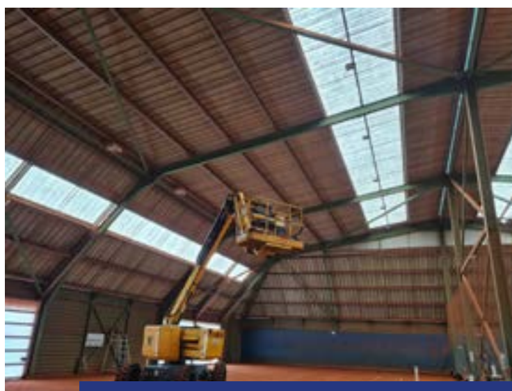
Economies d'énergie grâce à la technologie LED : changement des éclairages des tennis du Cardin
