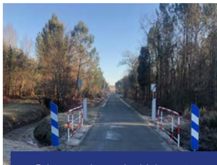
Peinture et mise en sécurité des ponts.
