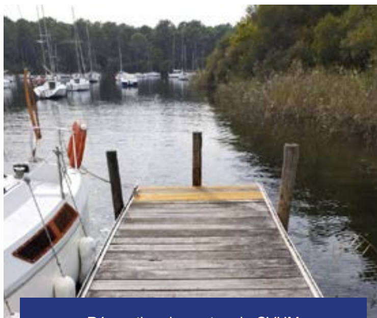
Réparation du ponton du CVHM
