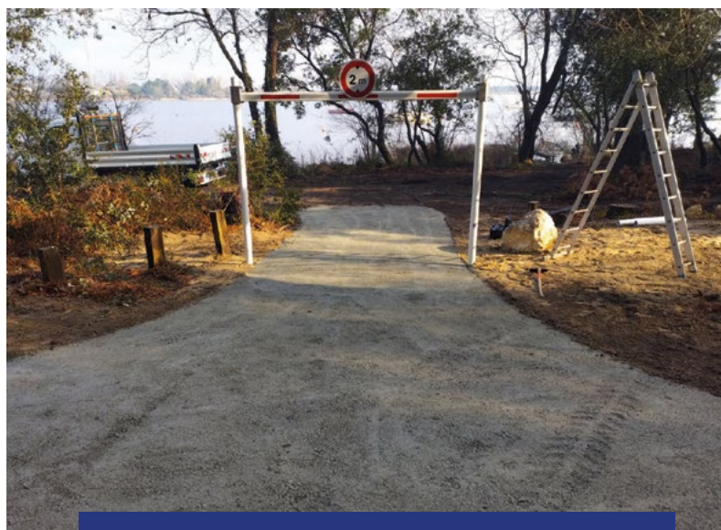
Pose d'un portique à gabarit fixe parking du Grand Mont à Piqueyrot
