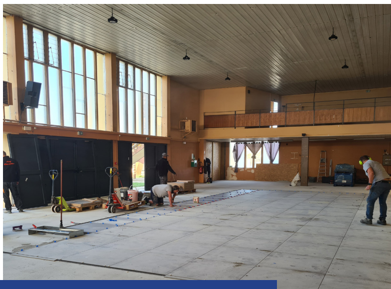
Salle des fêtes : Isolation du sol et pose de carrelage
