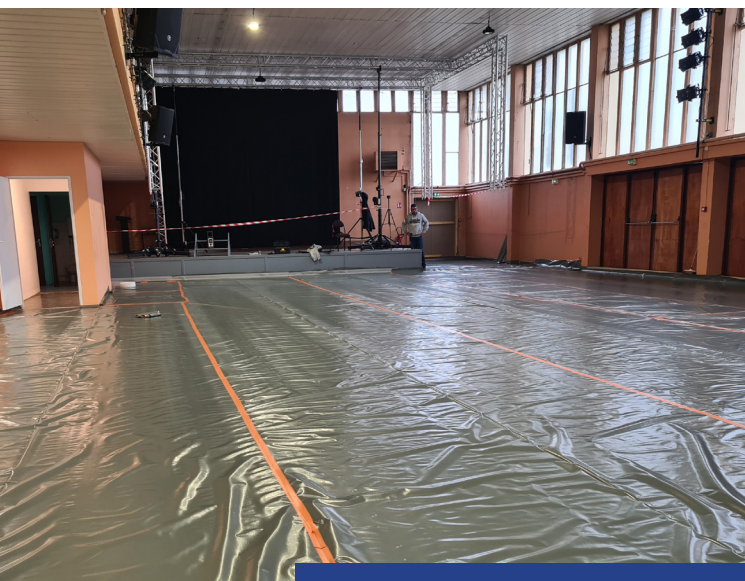
Salle des fêtes : Isolation du sol et pose de carrelage
